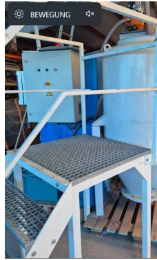
1.2 Treppe und Plattform
